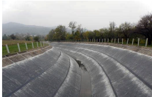
Vlasinske Hidroelektrane, Serbie, 3.200 m 2 , 2006-2008
